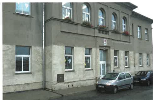
Původní fasáda ZŠ
