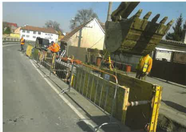
Výstavba kanalizace v obci
