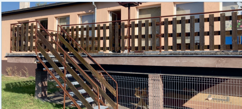
Terasa MŠ po rekonstrukci zábradlí a schodů
