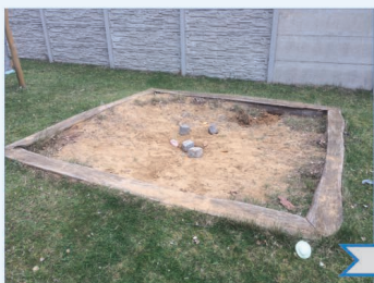
Pískoviště v areálu MŠ před a po rekonstrukci
