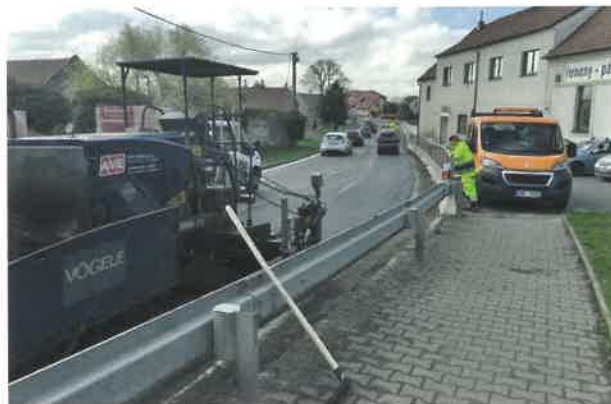
Oravné práce na povrchu vozovky v Hlavní ulici
