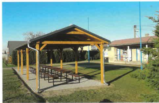
Úpravy terénu u nové pergoly na fotbalovém hřišti
