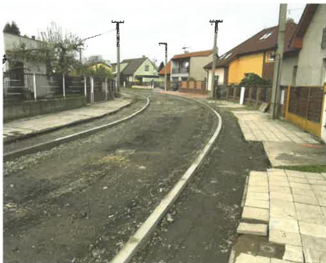
ul. Nová před rekonstrukcí
