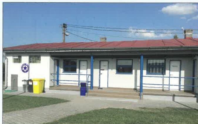
Kabiny SK - po rekonstrukci
