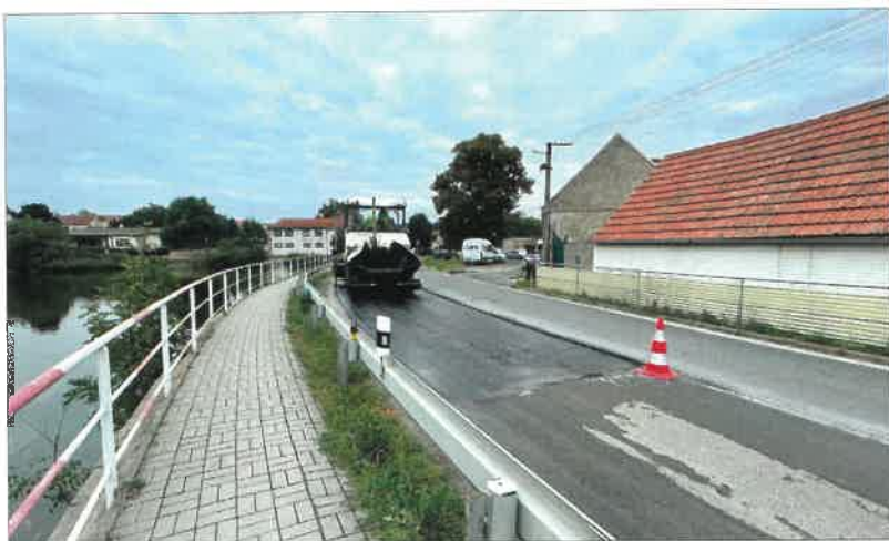
Oprava komunikace Hlavní
