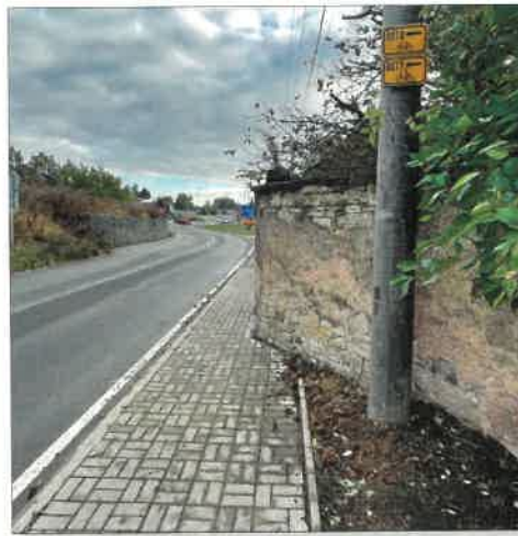
Přeložka sloupu v Kožovské ulici
